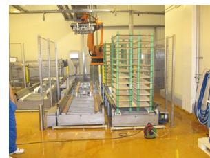
Kabeltromle på vådt gulv kan give stød!
