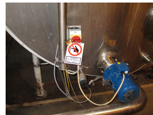
Skiltning om LOCK OUT. afbryderen til maskinen er slukket, og der er sat hængelås i.
