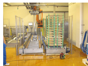
Kabeltromle på vådt gulv kan give stød!
