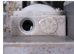
Den næste el-ulykke eller driftnedbrud er lige om hjørnet med ledningsdåsen fuld af vand.
